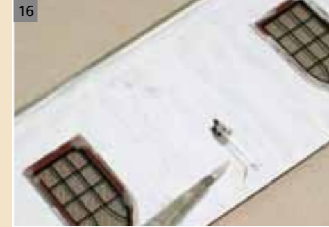
Die fertige Wandleuchte ankleben und die Drähte mit TESA-Klebeband überkleben sowie mit weißer Farbe kaschieren.
