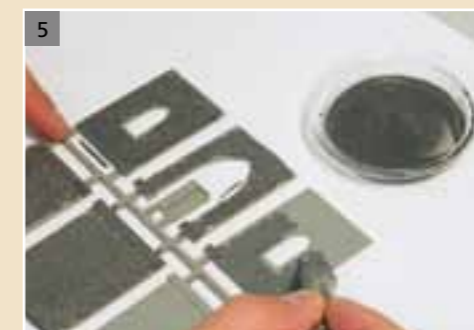
Feldsteinwände mit grauer Farbe streichen.
