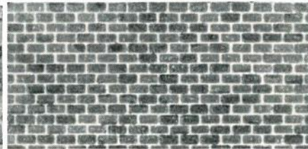
5/04 Ziegelmauerwerk Format 11 x 23 cm
